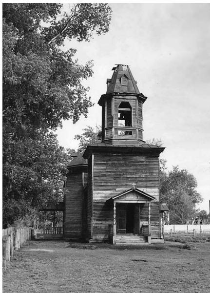
Рис. 9. Село Думчево, Залесовский район. Церковь. Фото 1998 г. Сгорела в 2004 г.
