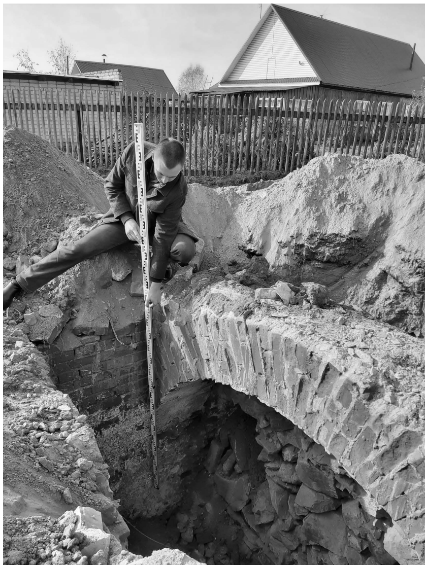
Рис. 4. Кладка южной стены подвального помещения. Вид с северо-востока. Фото Н. Н. Головченко.
