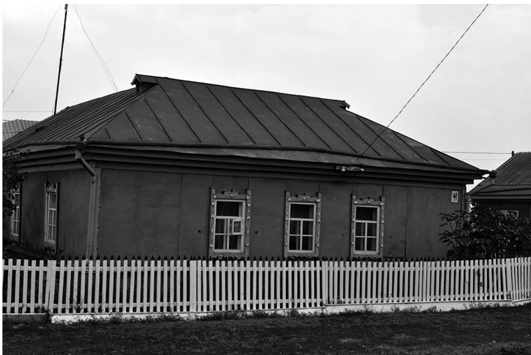
Рис. 6. Село Александровка, Азовский район Омской обл. Дом с вальмовой крышей. ПМ экспедиции МСНК-2012).
