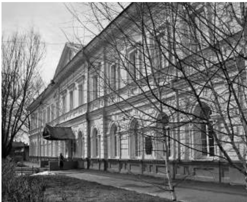
Рис. 3. Здание горного училища — часть ансамбля Демидовской площади. Арх. Я. Н. Попов, В. А. Шрейбер. Начало XIX в.
