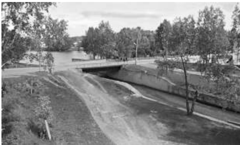
Рис. 1. Плотина Сузунского завода
