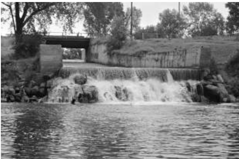
Рис. 2. Плотина Сузунского завода, вид со стороны водосброса
