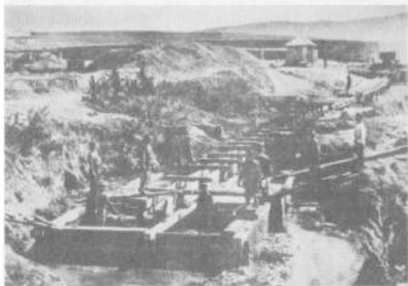
Зыряновская выщелачивальная фабрика. Американский шлюз для вымытия золота из остатков рудной породы. Фотография Борисова С. И.
