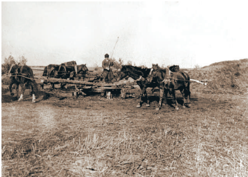
Конный привод молотилки. Первая четверть XX века
