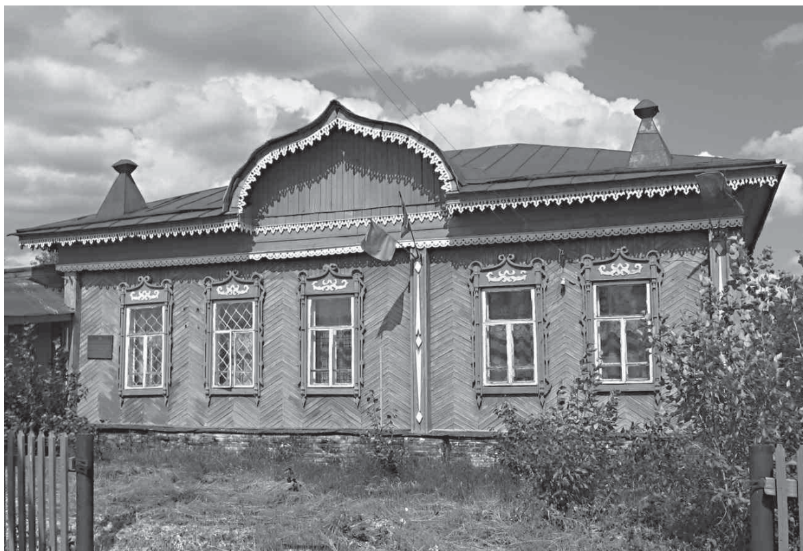
Рис. 2. Здание администрации в с. Рогозиха
